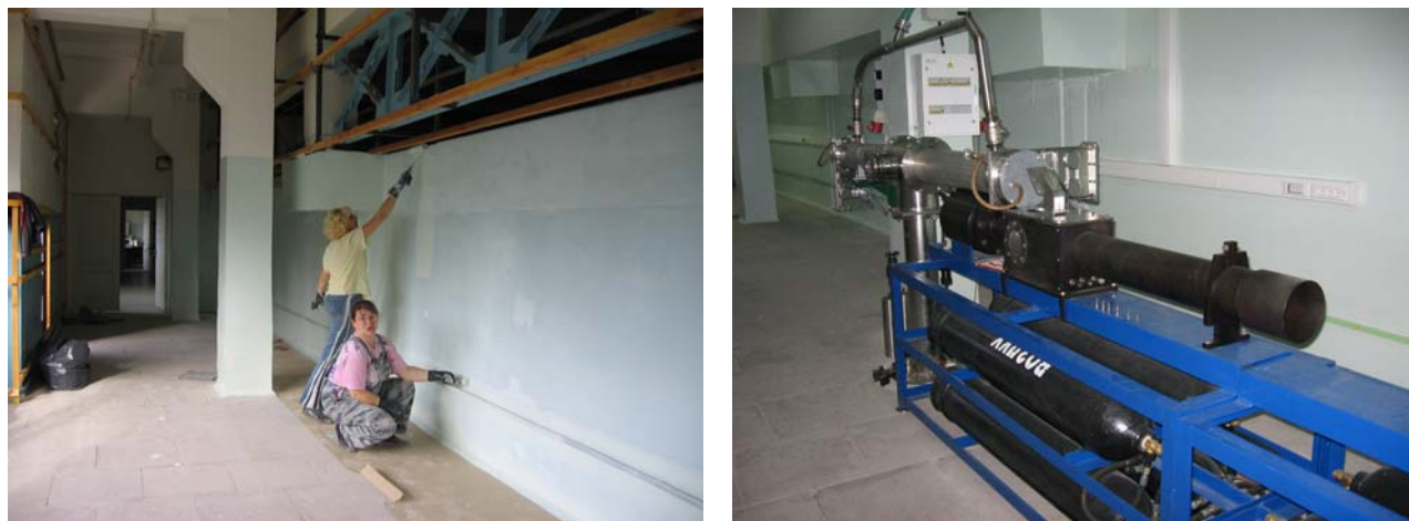
Рис. 30. Этапы строительства установки для исследования влияния терагерцового излучения на газовые потоки путем оптического зондирования в видимом диапазоне.
